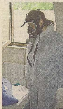
Schendel im Einsatz.
